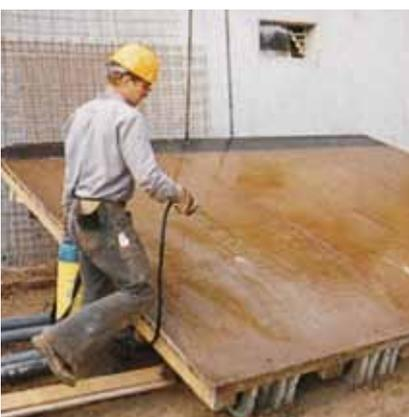
**Westag-Betonschalungsplatten** aus Furnierplatten bestehen aus wetterfest verleimten Hartholzfurnieren mit einer ausgeprägt niedrigen Feuchtigkeitsaufnahme und hochwertiger Oberflächenbeschichtung mit phenolharzimprägnierten Papieren. Die Schmalflächen sind mit einem Spezial-Acryl-Wasserlack wasserabweisend behandelt.
