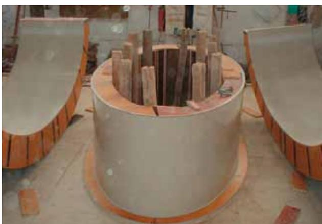
Schalung mit Rundform, Oberfläche mit Perform beklebt
