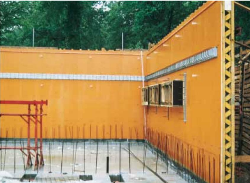
**Westag-Großflächen-Schalungsplatten** sind hervorragend geeignet für alle Arbeiten im Hoch- und Tiefbau, für Betonoberflächen mit normalen bis erhöhten Anforderungen, gemäß der DIN 18202, Teil 3, Zeile 5 bis 7.
